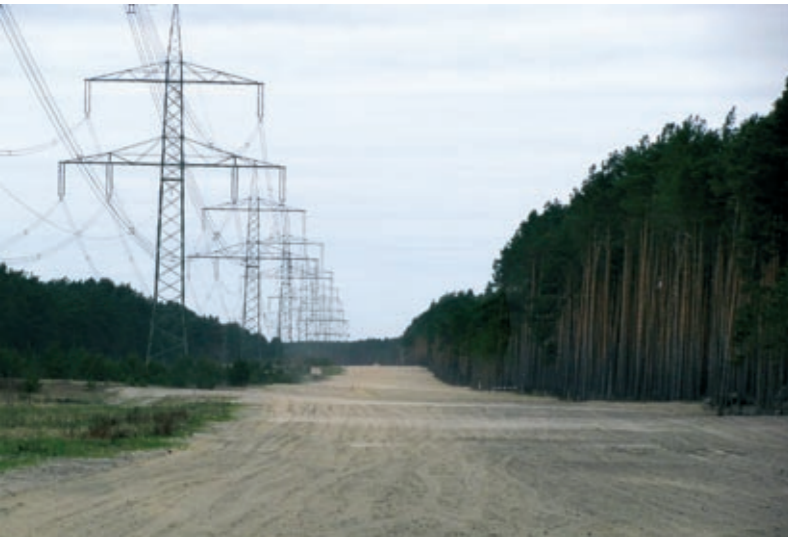
Trassenbündelung der OPAL mit anderen Energieleitungen
