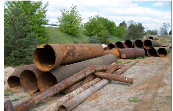
Rückbau Randriegelleitung
