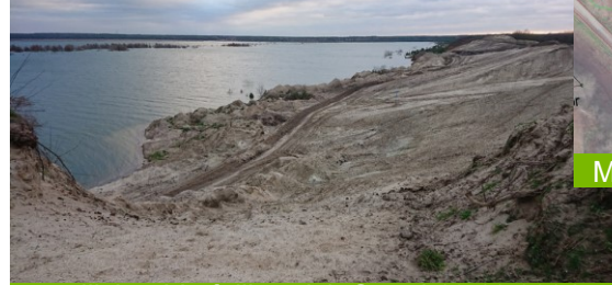
nördlicher Verfüllbereich Stand 18.12.2024
